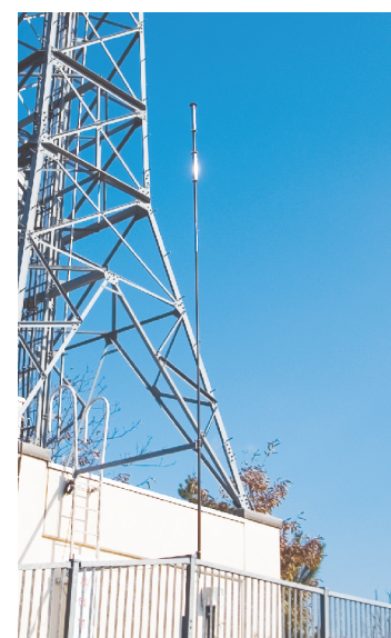
雷検知器設置 2
