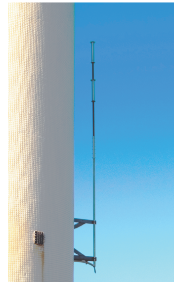
雷検知器設置 1
