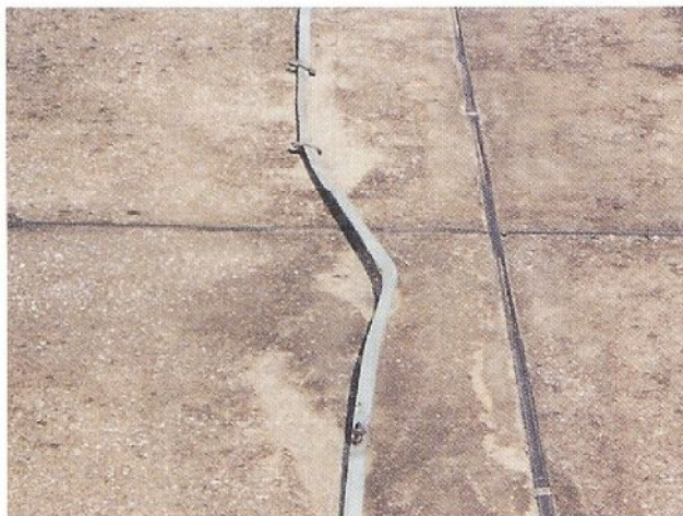
▲避雷銅帯が曲って銅帯取付金物がとれている
