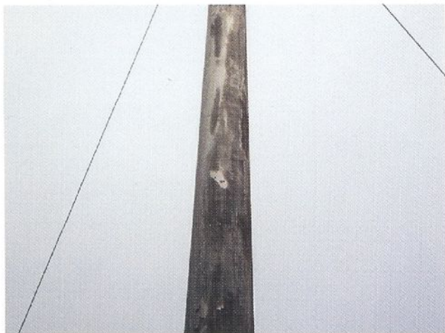
▲腐蝕している銅管ポール
