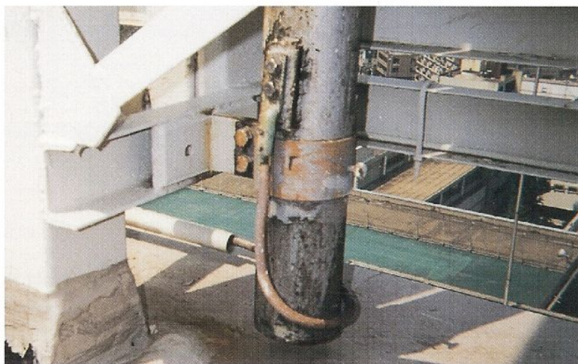
▲避雷針ポールが腐蝕しています。
