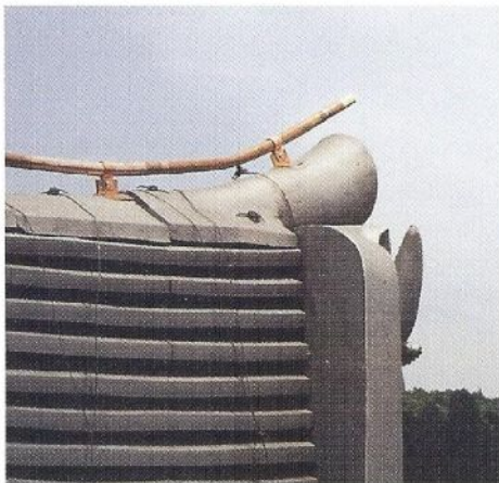
▲銅管用突針横型（施工例）
