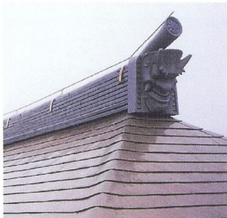
▲銅管用突針横型（施工例）
